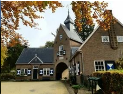
Poortgebouw De Ruiterberg
