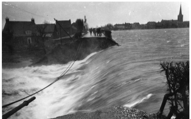
Foto van een dijkdoorbraak "je voelt de kracht van het water" Bron: website watersnoodmuseum
